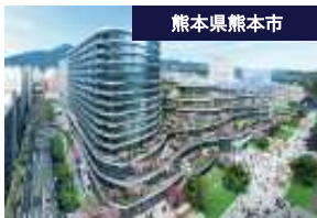
熊本県熊本市 ●ザ・熊本ガーデンズ 熊本都市計画桜町地区第一種市街地再開発事業 ※住宅棟
