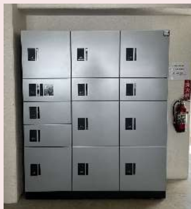
宅配BOX設置 (アルティザ東別院他)
