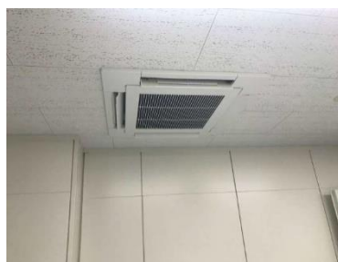
空調設備更新 (MRRデルタビル)
