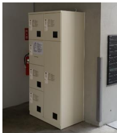
宅配BOX新規設置
