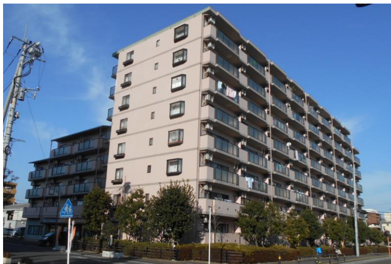
外観（タイル等補修）
