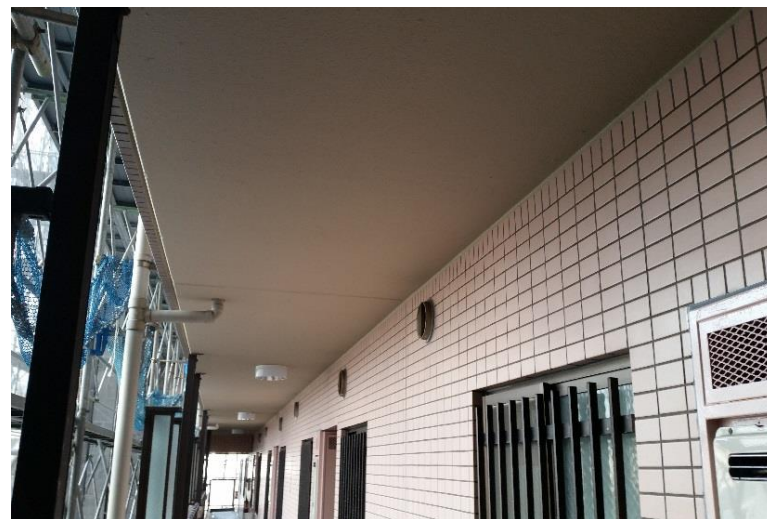
外廊下（廊下天井補修）
