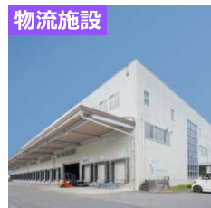
千代田町ロジスティクスセンター
