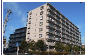
外観（タイル等補修）
