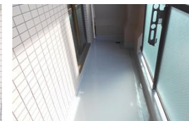
バルコニー（壁面補修、 床ウレタン防水補修）
