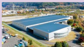
日本通運 駒ヶ根物流センター
