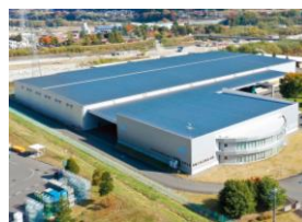
日本通運 駒ヶ根物流センター
