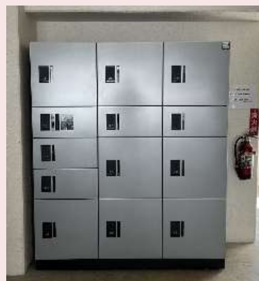
宅配BOX設置 (アルティザ東別院他)
