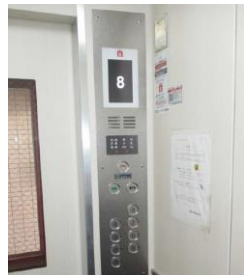
エレベーター改修工事
