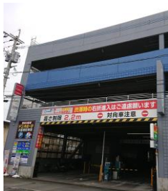
駐車場外壁塗装工事
