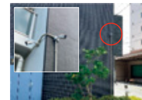
監視カメラ設置 (アルティザ淡路駅東他)
