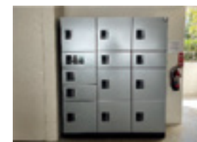
宅配BOX設置 (アルティザ東別院他)
